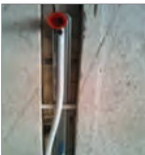
اتصال لوله به دیوار
