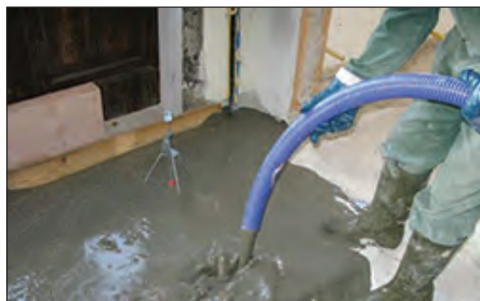
کف سازی ساختمان با فوم بتن
