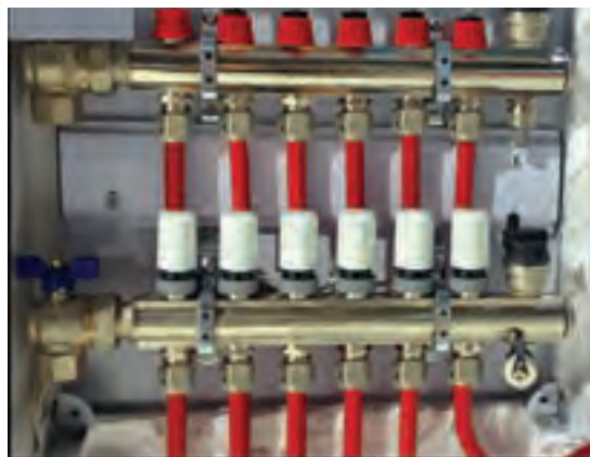
کلکتور سیستم کف گرمایی
