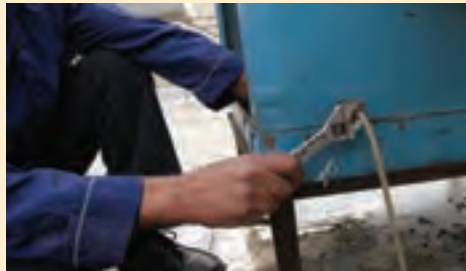
نصب لوله به شیر شناور
