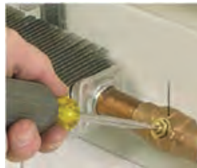
شیر هواگیری کنوکتور
