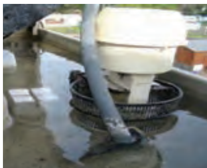
شیلنگ رابط پمپ و چهارراهی
