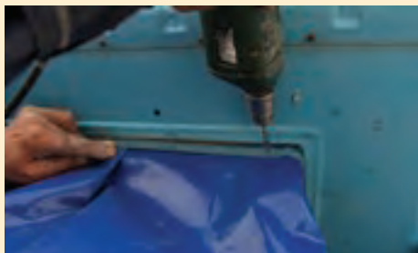
اتصال کانال توزیع هوا به دهانه کولر
