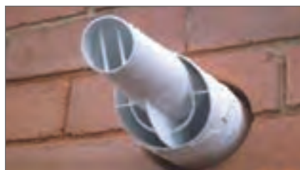
نقشه جزئیات یک نوع لوله دوجداره
